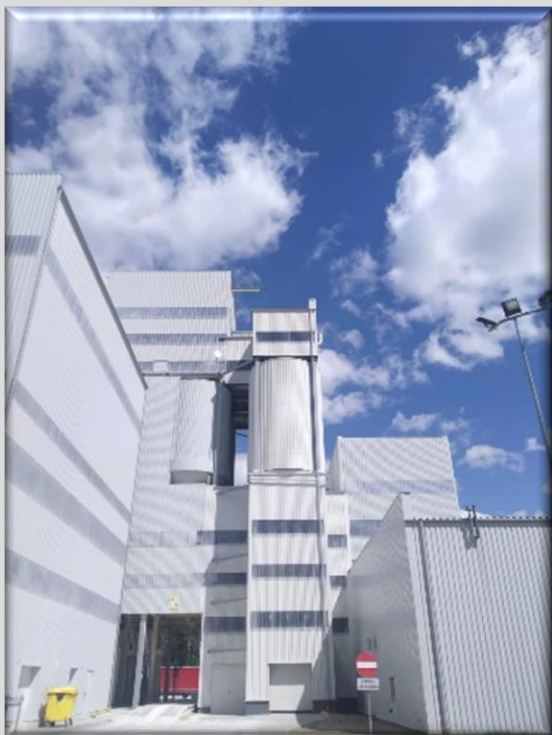
Fot. Paweł Walasek Obiekt zrealizowany
