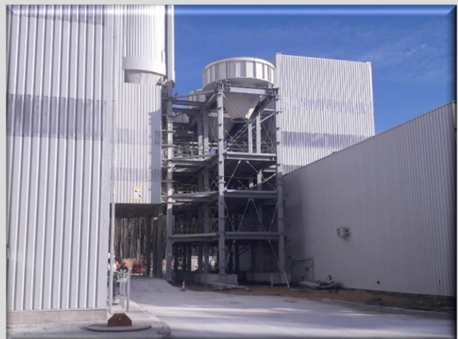
Fot. Paweł Walasek Montaż konstrukcji i silosów
